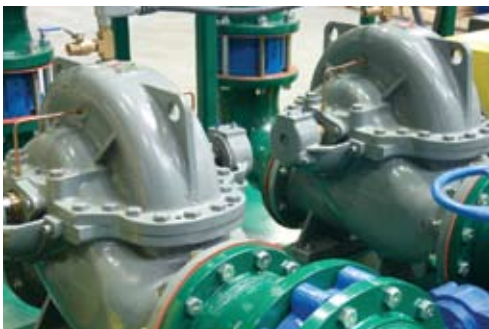
Estación de bombeo para elementos de agua en paisajes
